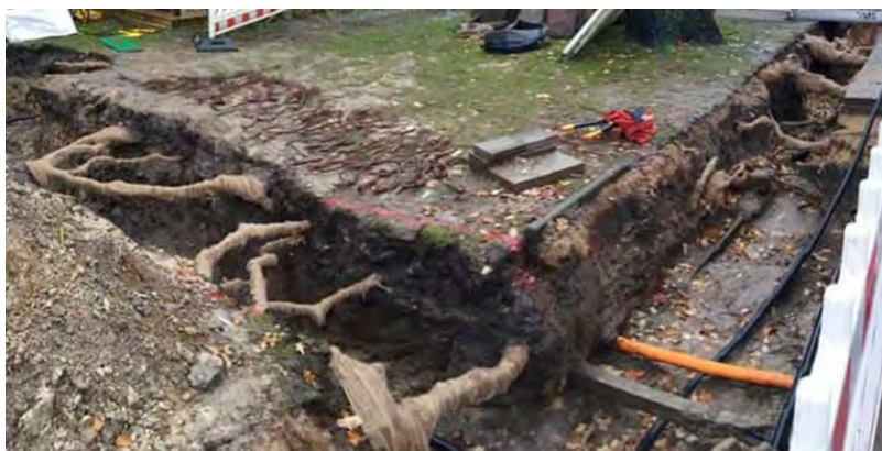
19 pav. Tranšėjos ir lovio kasimo išsaugant medžių šaknis pavyzdys
